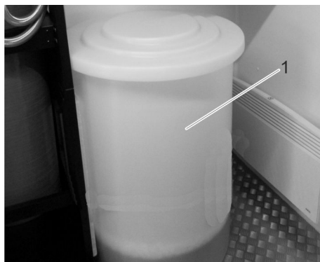
1 Réservoir de sel
